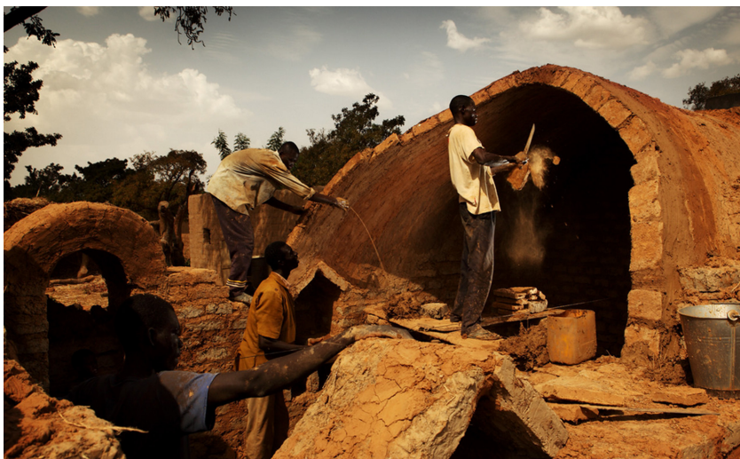
Enfants en visite sur le chantier d'une salle de classe à Godeln Sénégal.
