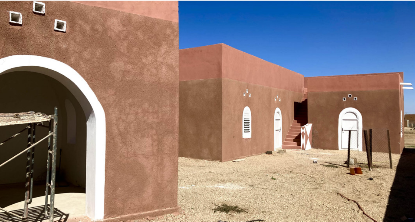
1. VN : Logement de Maîtres, Lycée de Fassala, Hodh El Chargui. (Photo Mathieu Hardy, 2022)
