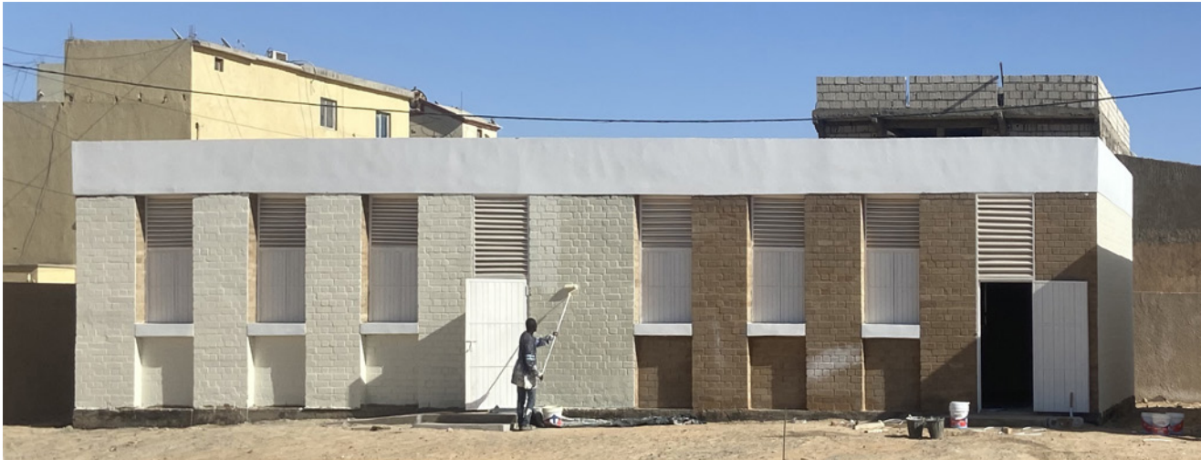
8. HYB : Salles de classe, école fondamentale de Sebkha, Nouakchott. (Photo Mohamed Lemine Dieng, 2023)
