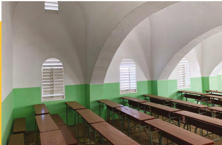
Espace ouvert entre les voûtes grâce à des arcs en bloc de béton plein pour une salle de classe d'une longueur de 9m50 et d'une largeur de 6m50.
