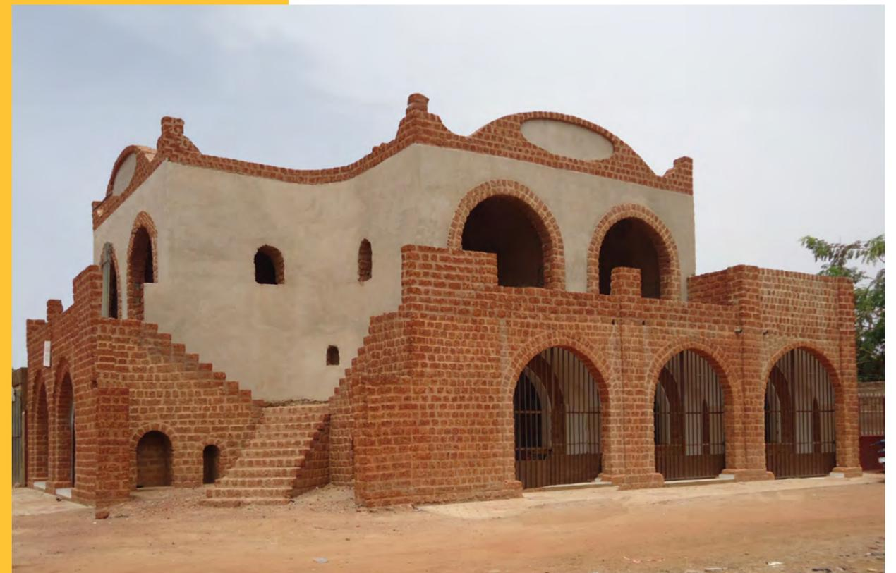
**Toiture terrasse :** la statique du concept technique Voûte Nubienne permet aux toitures terrasses de supporter des charges importantes. La donnée de charge acceptable est considérée comme étant sensiblement égale à celle d'un bâtiment conventionnel poteau poutre et dalle béton (environ 150-250kg/m<sup>2</sup>).
