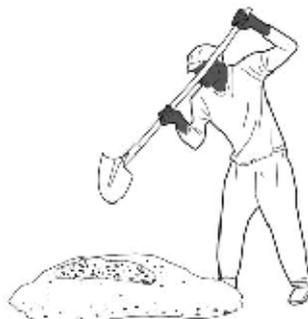
Mélanger le mortier d'argile grise avec le sable
