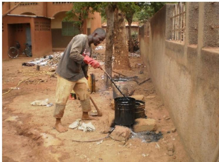
> La terre et le sable sont mélangés, mouillés et malaxés jusqu'à obtention d'un mortier de banco de consistance pâteuse.
