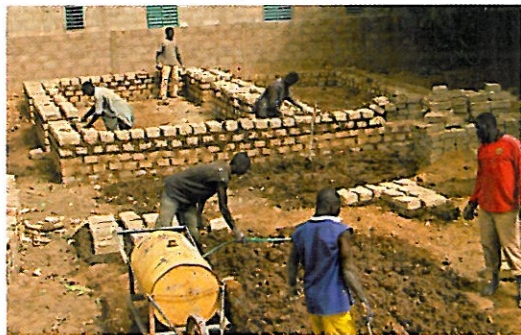
Sur des fondations de pierre, on élève des murs porteurs épais avec des briques croisées.
