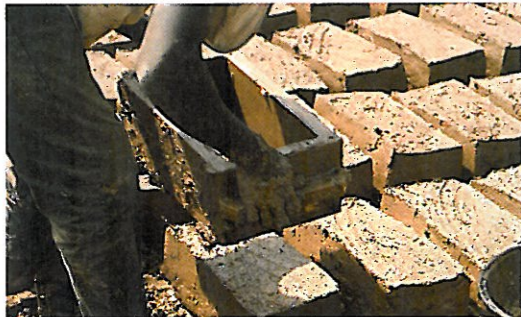
On utilise une matière première peu coûteuse, la terre crue, pour le mortier et des briques séchées au soleil.
