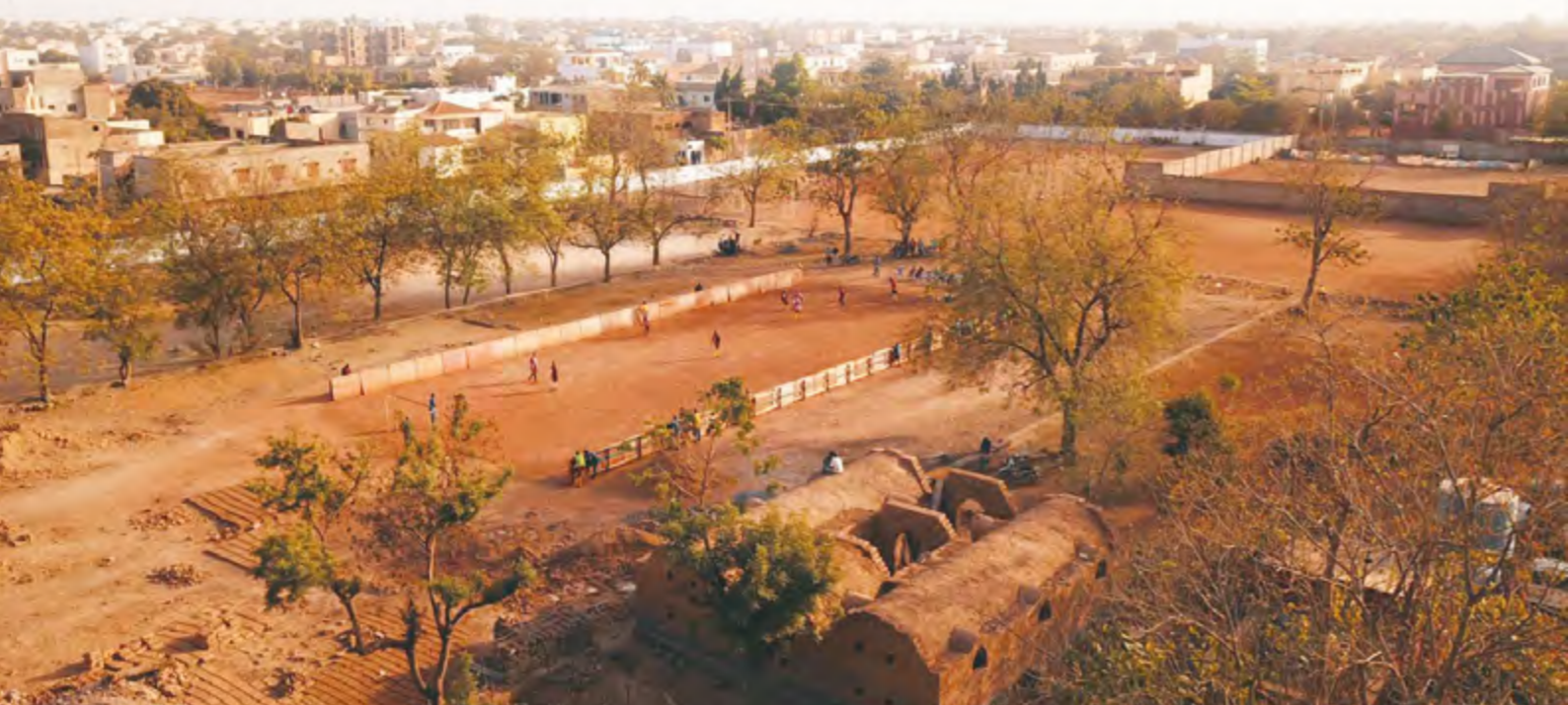
Vue aérienne du chantier du vestiaire Cecifoot (Association Libre Vue - © Atelier Martel).
