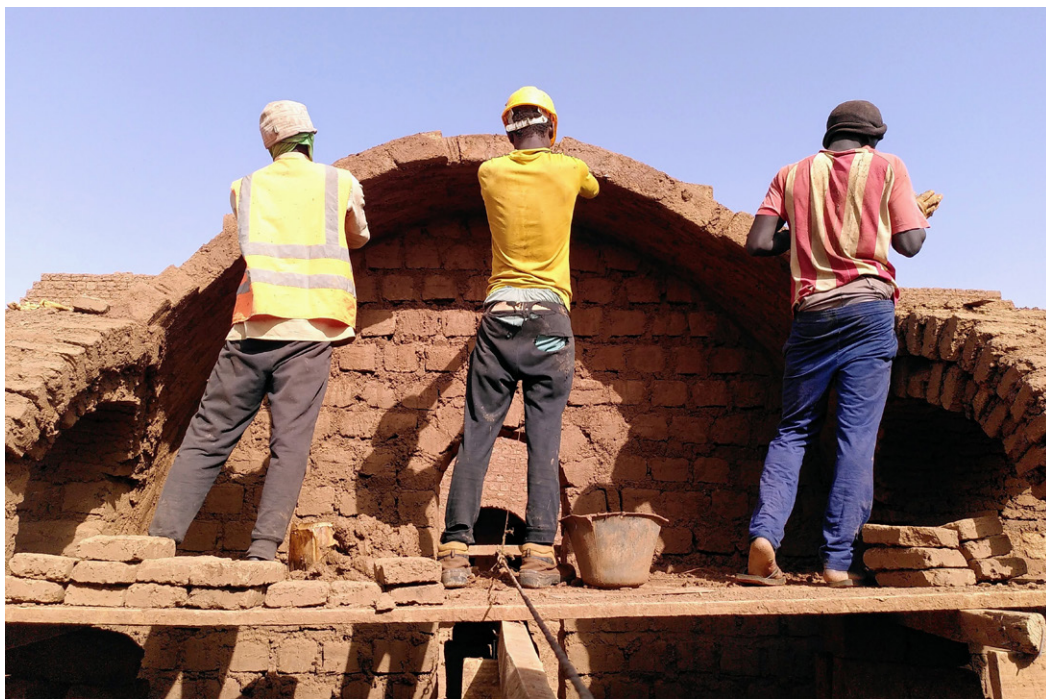
Trois maçons tirent la voûte dans sa longueur avec les briques de petit format et du banco-joint pour maçonner
