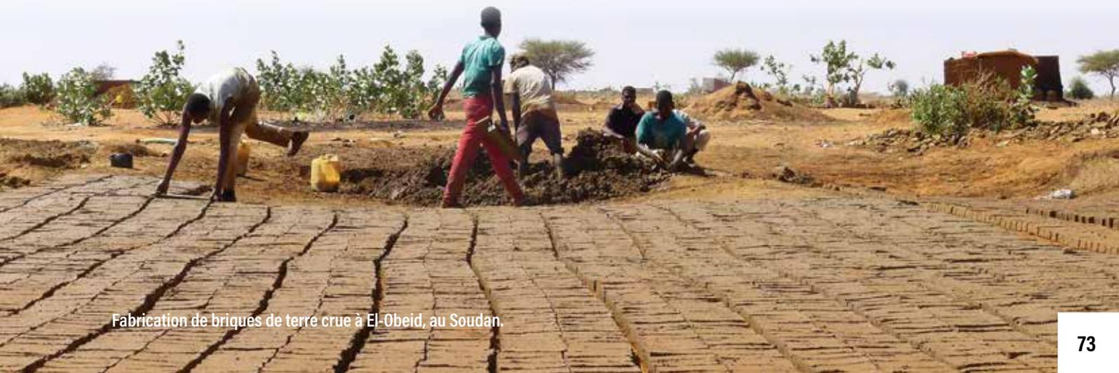
Fabrication de briques de terre crue à El-Obeid, au Soudan.
