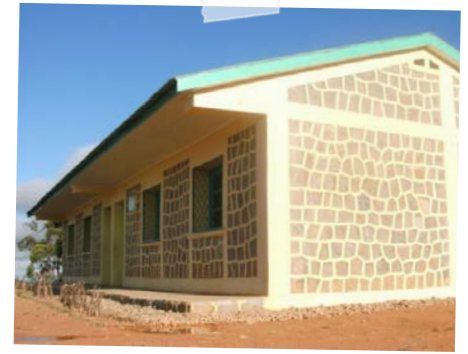
Ecole communautaire anticyclonique construite avec une matière première trouvée sur place, Hauts-plateaux, Madagascar.
