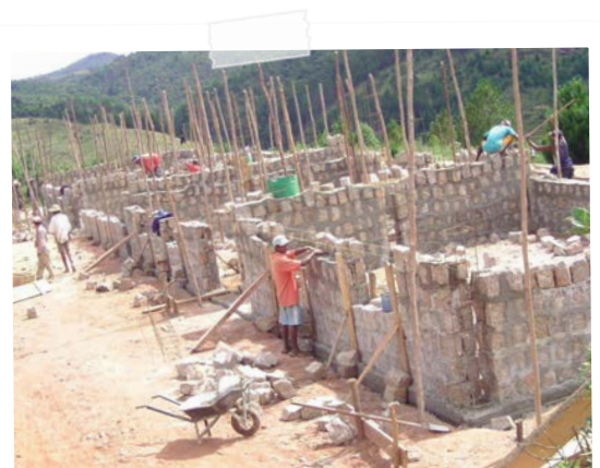
Maçonnerie des murs, Madagascar.
