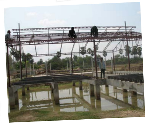
Construction de salles de classe sur pilotis, Cambodge.
