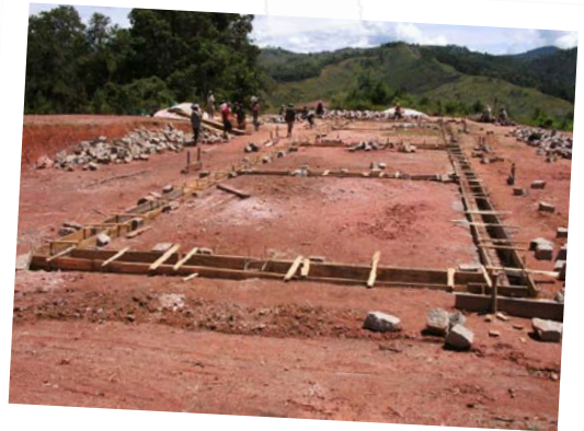
Réalisation des fondations du bâtiment, Madagascar.
