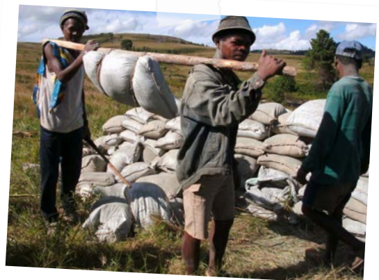
Transport des sacs de ciment pour la construction d'un bâtiment en zone enclavée, deux jours de marche à pied, Madagascar.
