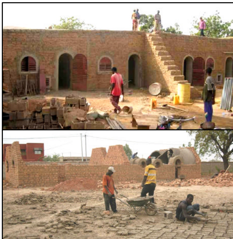
Figure 26 : Ouagadougou, Chantiers à Gounghin et Ouaga 2000, Ouvrages servant comme chambres d'accueil ; Photos : Wyss '05
