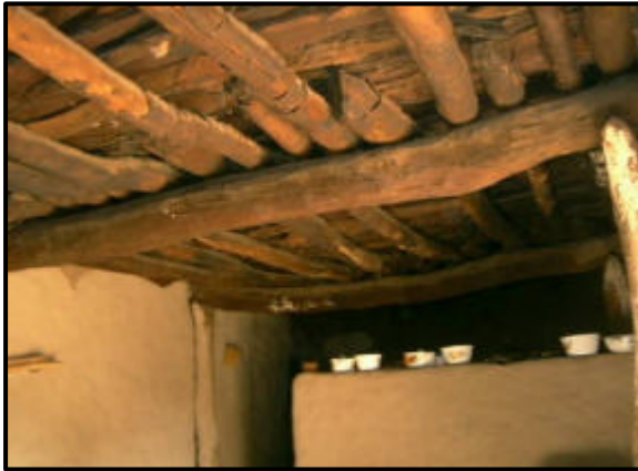
Figure 4 : Charpente traditionnelle : bois rond supportant terrasse en terre ; Charpente moderne : bois équarris, surmonté de tôle ; Sillou '05
