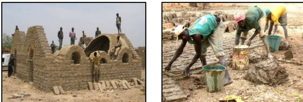
Figure 20 : Datomo, Réalisation VN - Mobilise de beaucoup de main -d'œuvre ; Ouagadougou, Briquetiers VN ; Photos: Sillou et Wyss '05
