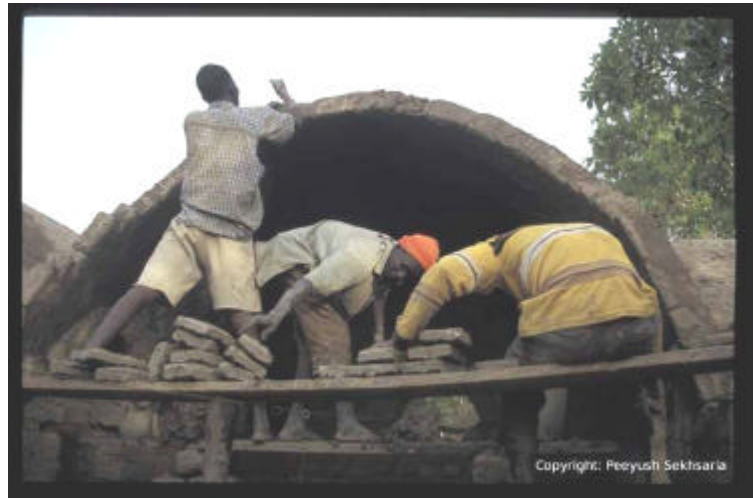
Figure 10 : Boromo, réalisation voûte ; Photo : P. Sekhsaria, 2005
