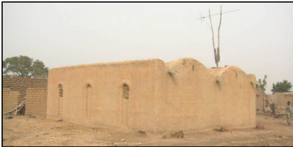
Figure 22 : Etoayou, VN servant à l'habitat et au stockage de coton, Plaque photovoltaïque et TV intégrées ; Photo : Wyss '05
