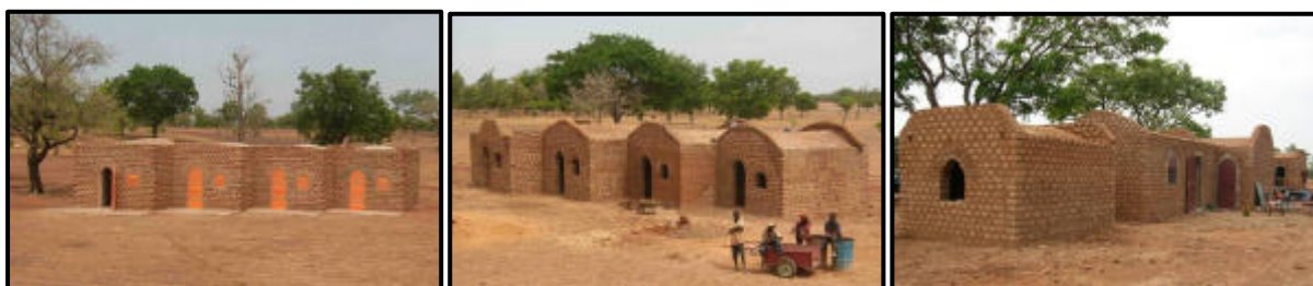
Figure 21 : Samandéni, A gauche : Lot n°1, 4 VN servant comme chambres d'accueil, pied-droits en BLT, 2004 Centre, Lot n°2, 4 VN servant comme chambres d'accueil, partiellement en BLT, 2004/05 A droite : Lot n°3, poulailler, logements gérant et cuisinier, cuisine, entièrement en terre, 2005 ; Photos: Wyss '05
