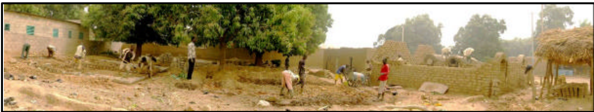
Figure 7 : Boromo, Vue panorama d'un chantier VN. A gauche : maçonnerie des murs porteurs (pieds-droits) et pignons.
